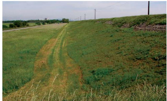
Digue du Grand Canal d'Alsace à Blodelsheim - Photo : © L. DIETRICH/CSA
